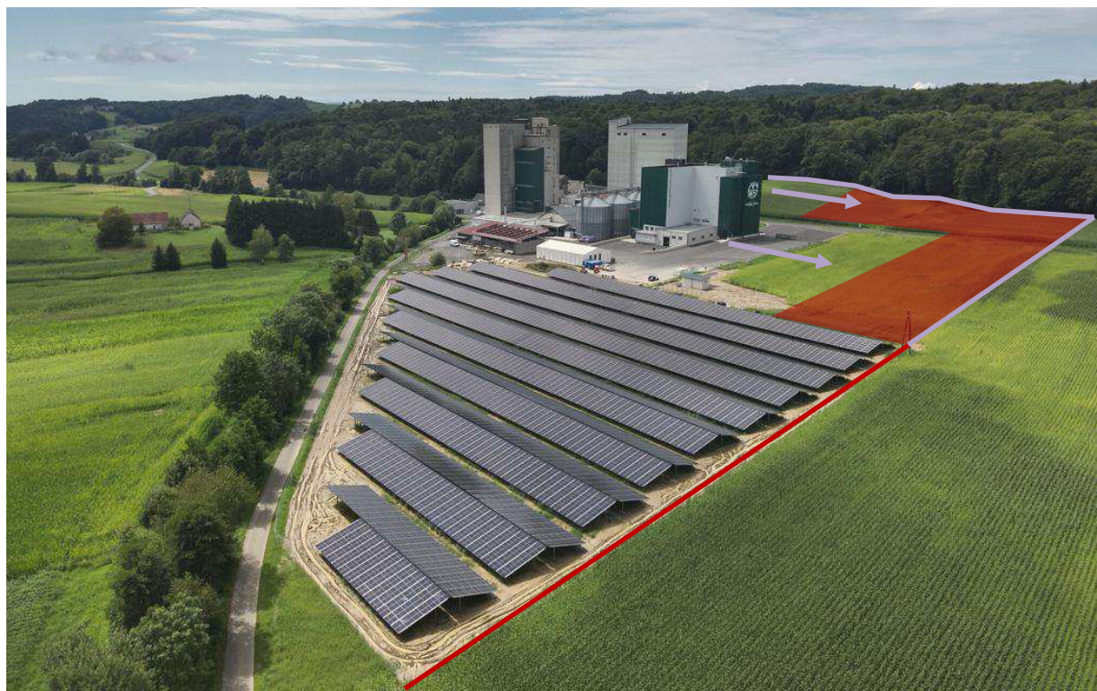
Abb. 3 Aufnahme des Betriebsstandorts von Nordosten inkl. die errichtete PV-Anlage sowie der Erweiterungsbereich der Flächenwidmungsplanänderung 1.12 (rot), (Quelle: https://www.meinbezirk.at )
